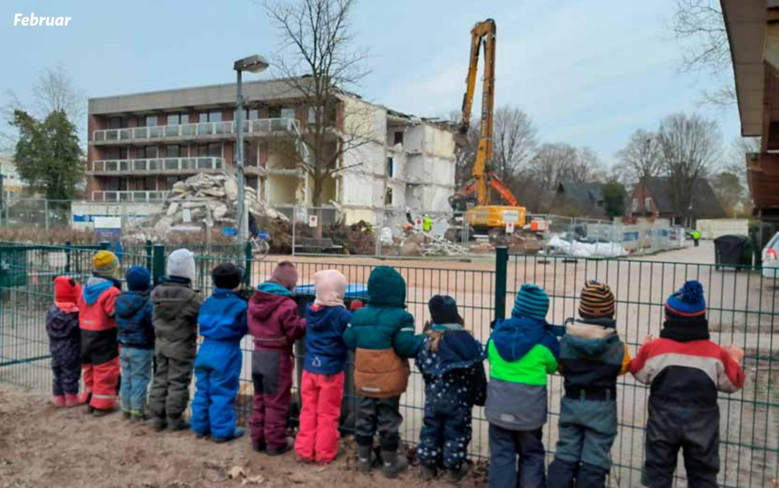
Schneller Baufortschritt in Hamburg
