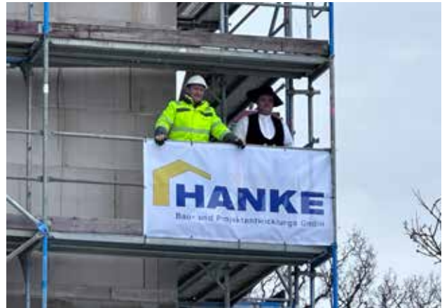
Unser Bauleiter Herr Zieseniss von der Firma Hanke Bau verkündet den Richtspruch.
